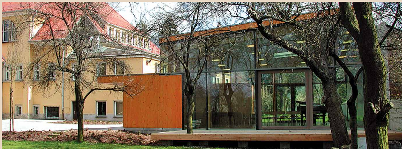
Der 2001 eröffnete neue Chorsaal auf dem Campus der Hochschule.
